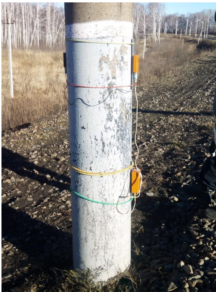
Рис 1. Расположение вибродатчиков на центрифугированной железобетонной опоре
